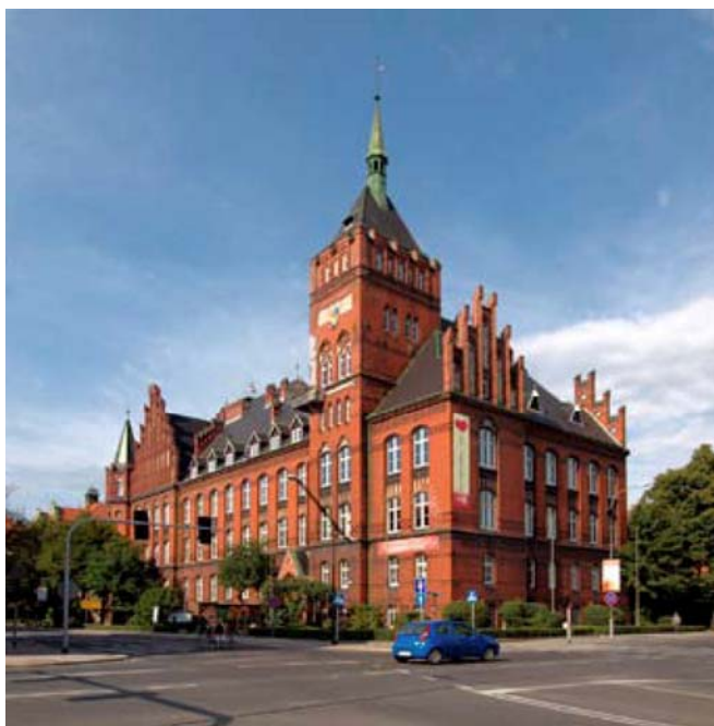
Gmach Wydziału Chemicznego Politechniki Śląskiej – stan aktualny.
